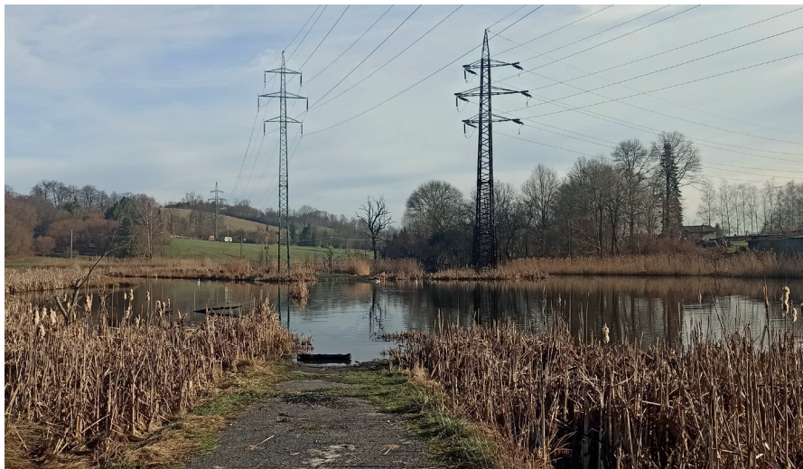
Charakteristický je vznik nových vodních ploch - poklesové jezero se zaplavenou místní komunikací.
