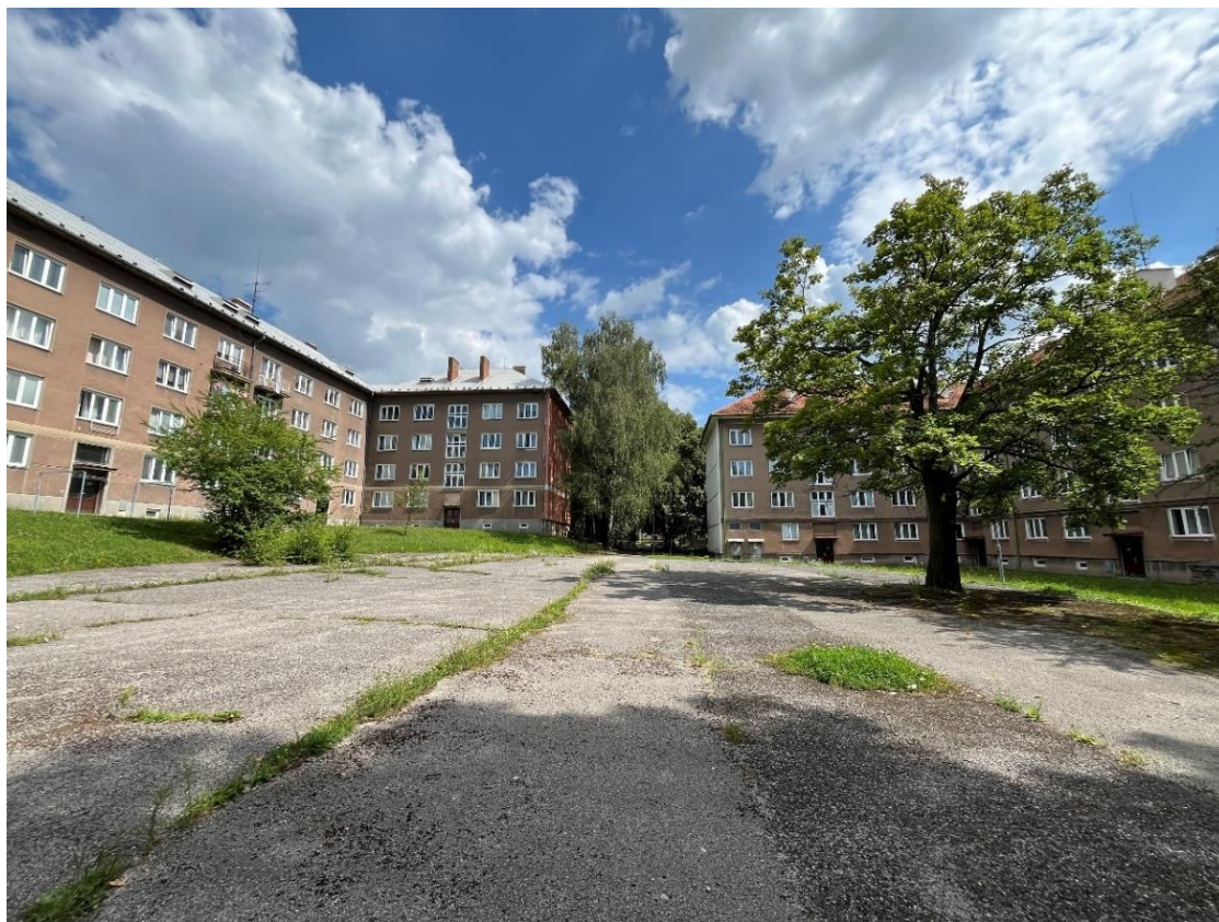
Současný stav: rozsáhlá asfaltová plocha v obytném souboru, prostor bez náplně
