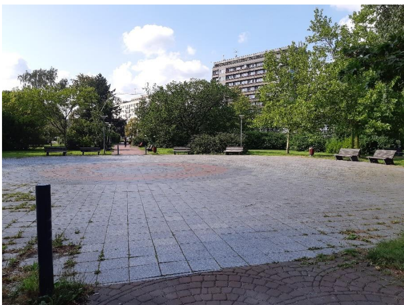
Fotografie současného stavu: Předimenzovaná nepropustná zpevněná plocha
