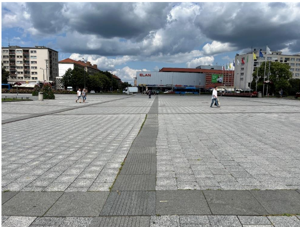
Fotografie současného stavu: rozsáhlá zpevněná plocha z nepropustné dlažby
