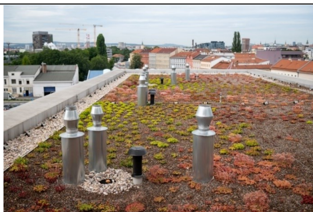
Zelená střecha v Brně na ul. Svatopeterská
