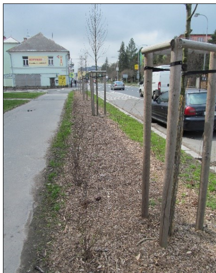
Výsadba stromů do pruhu trávníku mezi chodníkem a komunikací (ulice Jesenická, Bruntál)
