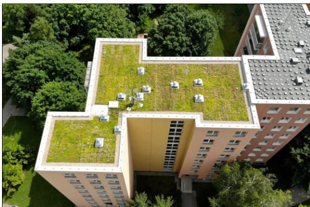
Zelená střecha bytového domu v Brně Bohunicích
