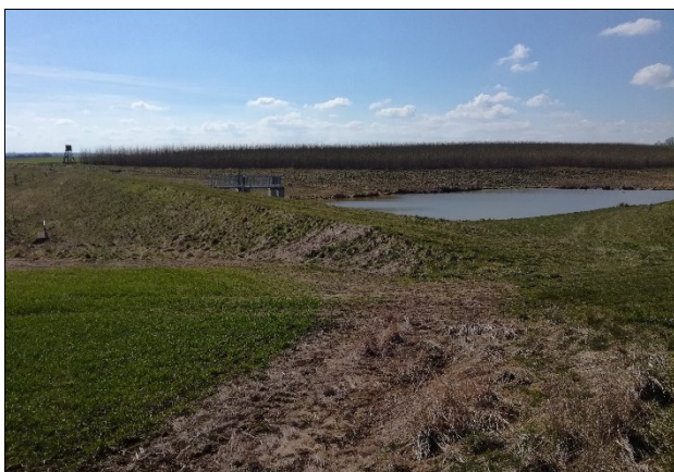
Suchá nádrž Bravantice slouží k zadržení srážkových vod z okolního svažitého terénu
