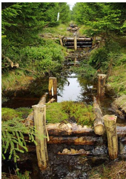
Obrázek 1-18: Soustava menších dřevěných přehrázek na toku
