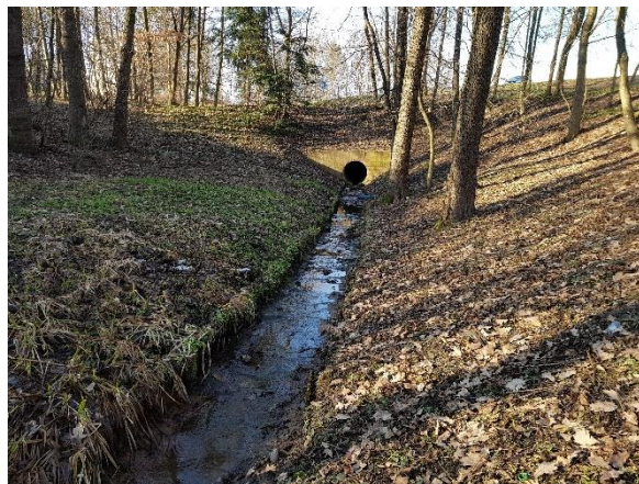
Obrázek 1-85 Odvodnění parku, ul. Moravská
