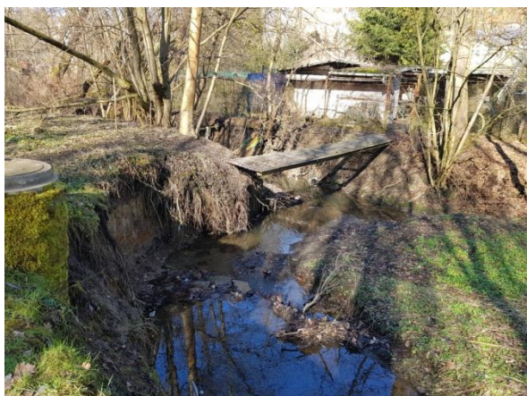
Obrázek 1-42 Břehy toku Stružník s projevy boční eroze
