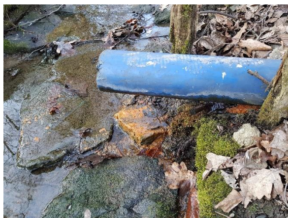
Obrázek 1-91 Odvodnění parku, ul. Moravská
