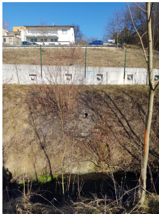
Obrázek 1-47 Břehy toku Stružník s projevy boční eroze
