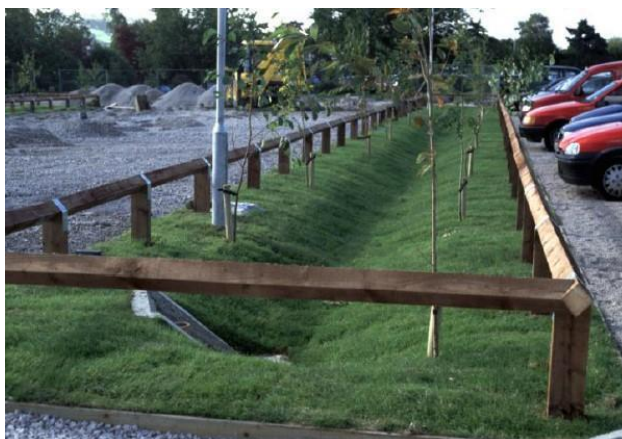
Obrázek 2-1: Schematické znázornění průlehu a příklad průlehu u parkoviště (vpravo)
