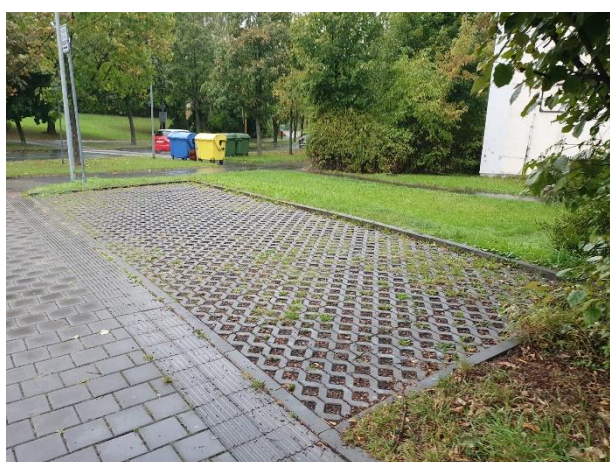
Obrázek 2-36 Ukázka využití zatravnovacích tvárnic, příklad dobré praxe
