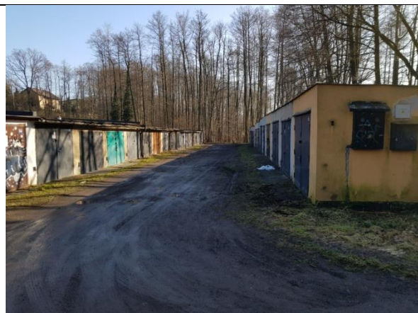
Obrázek 1-79: Pohled na garáže pod ulicí Lidická.
