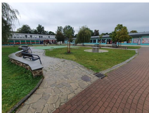
Obrázek 2-35 Příklad četného nevhodně i nevkusně revitalizovaného prostoru náměstí
