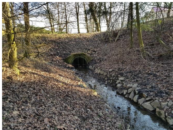
Obrázek 1-93 Odvodnění parku, ul. Moravská
