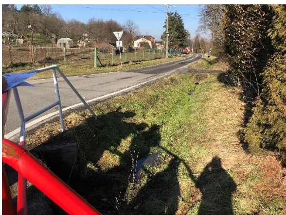
Obrázek 1-12 Pohled na vsakovací příkop podél ulice Na Důlněku v místě křížení s ulicí Mezidolí
