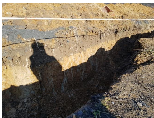
Obrázek 1-53 Výkop pro pokládku kanalizace u kruhového objezdu.
