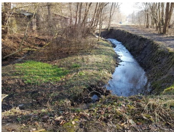
Obrázek 1-43 Břehy toku Stružník s projevy boční eroze
