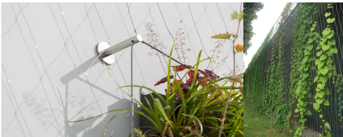
Obrázek 2-52 Uchycení a vedení popínavých rostlin po konstrukci z ocelových lanek
