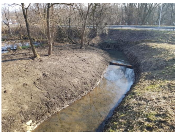
Obrázek 1-68 Pohled na nátok do zatrubněné části Šumberského potoka pod ulicí Orlovská, česle na nátok.
