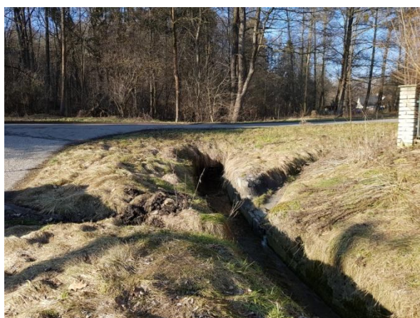
Obrázek 1-76: Zaústění odvodňovacího rigolu do Šumbarského potoka. Pohled na ulici Školní, vjezd ke garážím.
