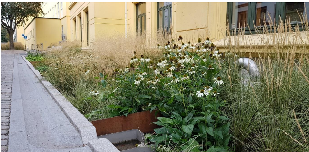
Obrázek 2-5 Deichmans gate, Oslo – delší dešťové záhony jsou odděleny železnou cortenovou stěnou pro maximální využití objemu pro vodu. Přítok má záchytné dno pro sedimentaci větších částic a zamezení eroze
