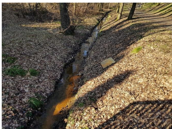
Obrázek 1-88 Odvodnění parku, ul. Moravská
