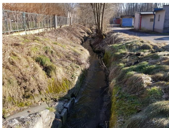
Obrázek 1-77: Pohled na Šumbarský potok a garáže.
