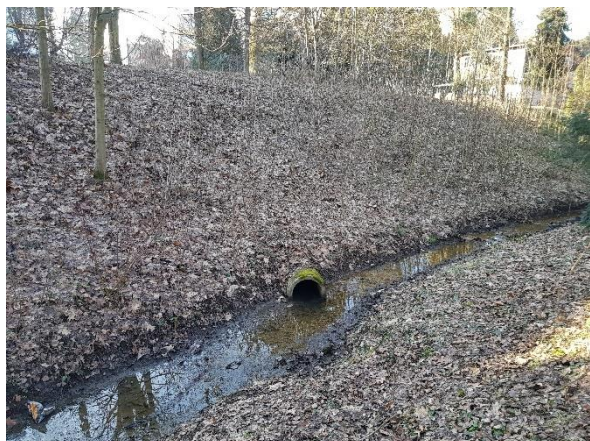
Obrázek 1-92 Odvodnění parku, ul. Moravská
