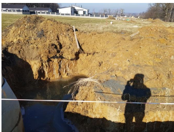
Obrázek 1-52 Výkop pro pokládku kanalizace u kruhového objezdu.
