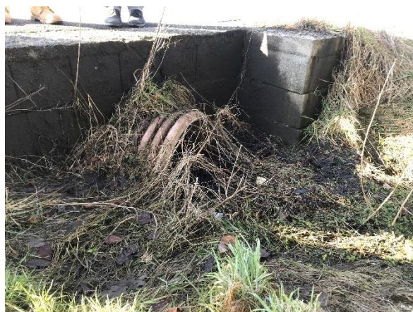
Obrázek 1-13 Propustek v místě křížení ulic Mezidolí a Na Důlněku
