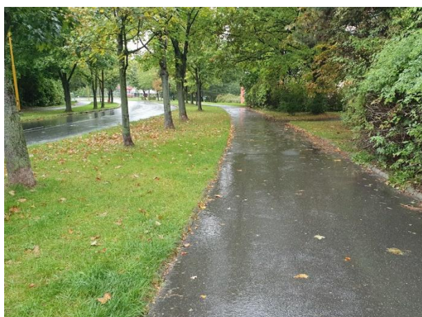
Obrázek 2-8 Potenciál pro svedení srážkové vody z chodníku do průlehu v zeleném pásu
