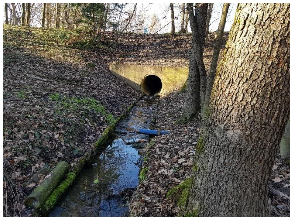
Obrázek 1-84 Odvodnění parku, ul. Moravská
