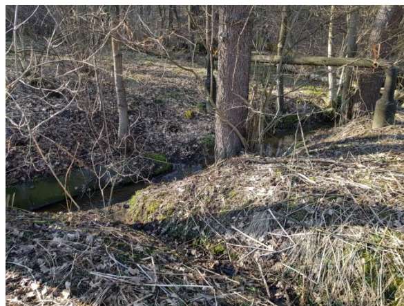
Obrázek 1-75: Zaústění odvodňovacího rigolu do Šumbarského potoka.
