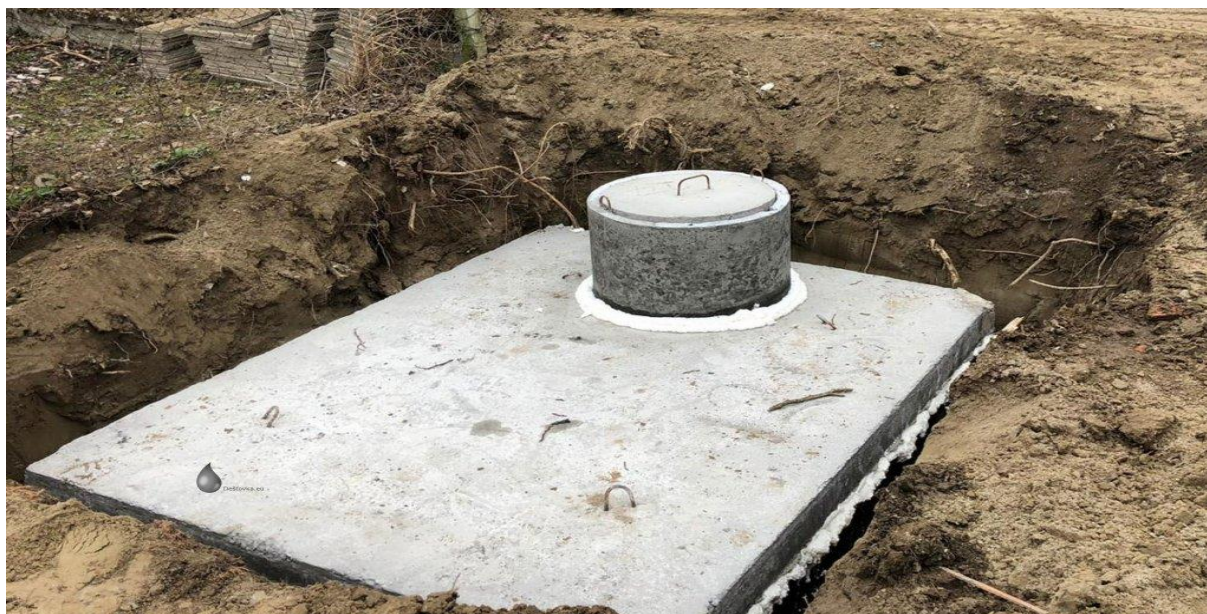
Obrázek 2-61 Příklad – betonová jímka na dešťovou vodu
