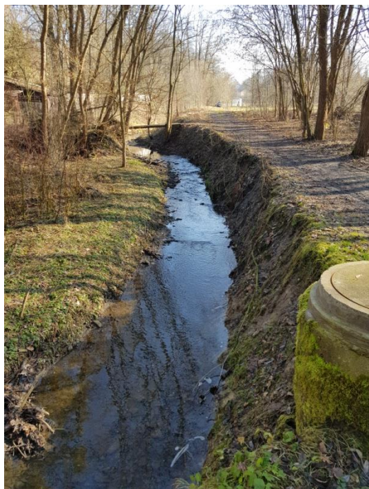
Obrázek 1-46 Břehy toku Stružník s projevy boční eroze
