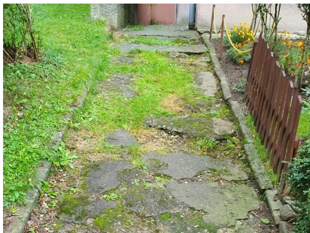
Obrázek 2-40 Ukázka přirozené degradace zpevněného povrchu, nabízí se zatravnit
