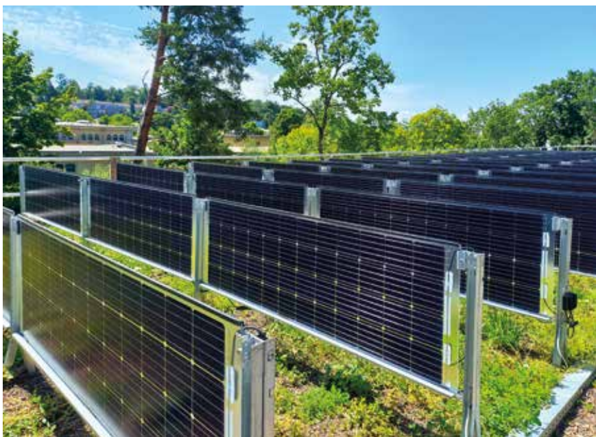
Vertikálně orientované bifaciální FV panely na modrozelené střeše z dílny Andrease Dreisiebnera. Vegetace je založena pomocí regionálních bylin. Foto: Pavel Dostal
