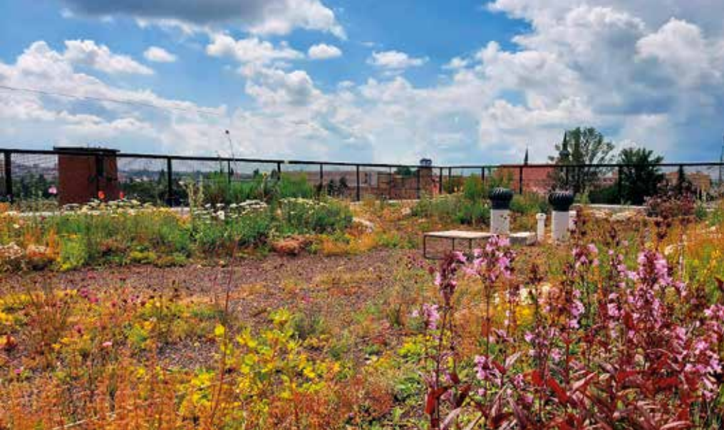
Polointenzivní zelená střecha. Brno, DADA District. 1. místo v soutěži Zelená střecha roku 2022.
