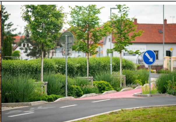
Realizace odtoku srážkové vody z komunikace (Roudnice nad Labem)
