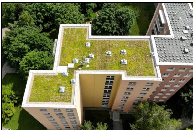
Zelená střecha bytového domu v Brně Bohunicích
