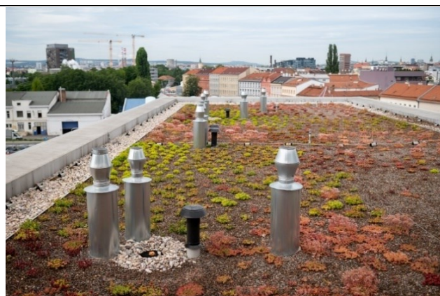
Zelená střecha v Brně na ul. Svatopeterská
