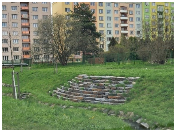
Posedové schody u revitalizovaného toku Kobyliho potoka (Bruntál)
