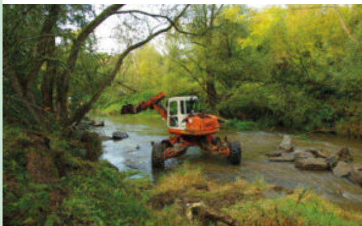
Podpora samovolné renaturace (přirozené obnovy) řeky Moravy u Štěpánova. Kamenné opevnění zmizelo, břehy se postupně vymýlají, koryto se změlčuje, a tak dochází k žádanému zadržování vody v krajině. Foto: Povodí Moravy, s. p., David Veselý
