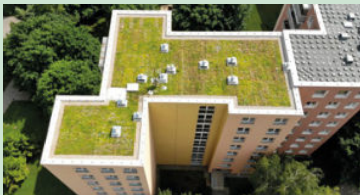
Vegetační střecha na panelovém domě v Brně-Bohunicích. Takovéto střechy mají význam jak pro obyvatele budovy, tak i pro její okolí – v létě ochlazují a v zimě omezují úniky tepla, při deštích zadržují vodu, čímž omezují nápor na kanalizaci a ulivu na vodní toky. Foto: GreenTop, s. r. o.
