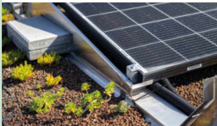
Biosolární střecha na škole Českobrodská v Praze 9 – příklad synergie adaptačních a mitigačních opatření. Foto: Nadace Partnerství, Vojta Herout
