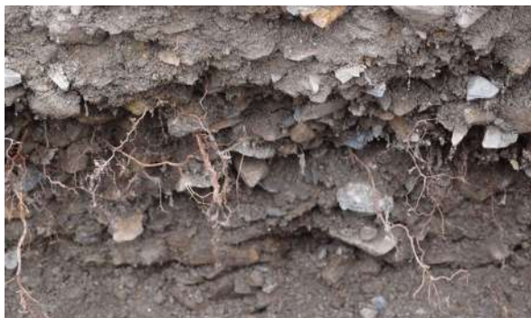
Obr. 8 Prokořeněná vrstva pod chodníkem
