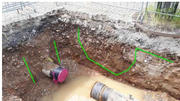
Obr. 9 Prokořenění ve více provzdušněných vrstvách a v zásypu plynovodu
