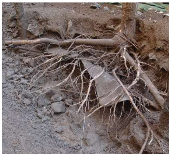
Obr. 11 Přerůstání kořenové bariéry
