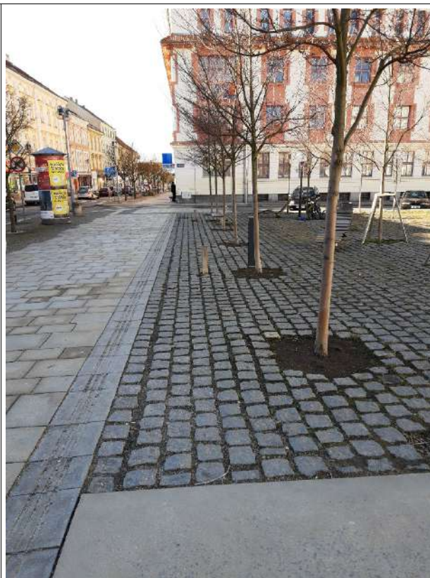
Obr. 42 Provedení široké spáry s vegetačním prvkem
