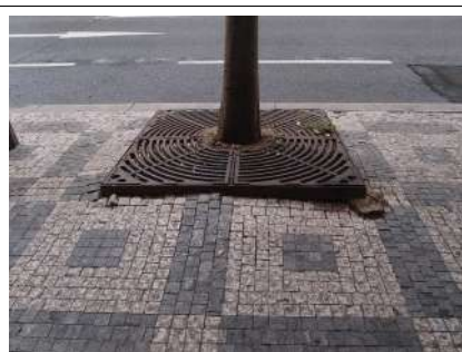
Obr. 12 Zvýšení hrany blokuje nátok vody
