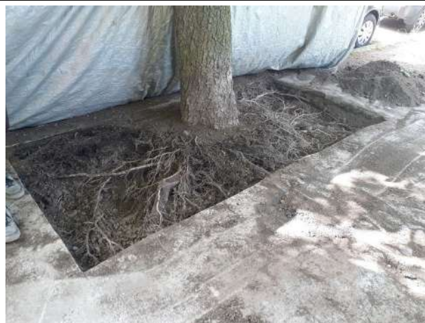
Obr. 47 Využití nedestruktivního způsobu výkopu v oblasti SVKT a KKZ
